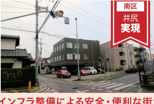
環状線ができて抜け道となった井尻4丁目平原橋交差点は、車の通行量が増えて事故が多発していました。安全対策としてカラー舗装、点滅信号、横断歩道を設置しました。
